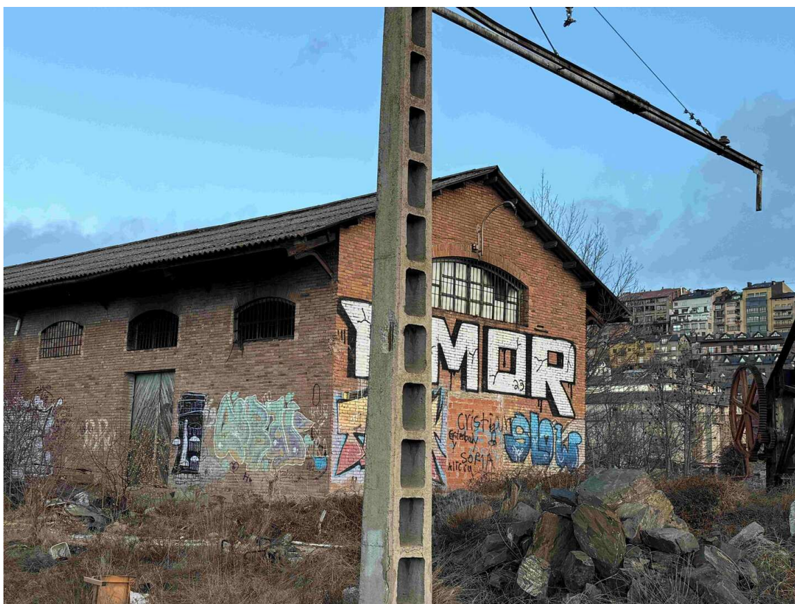
Nau incendiada pròxima al polígon del Sector de l'Estació de Puigcerdà / Feliu Sirvent
