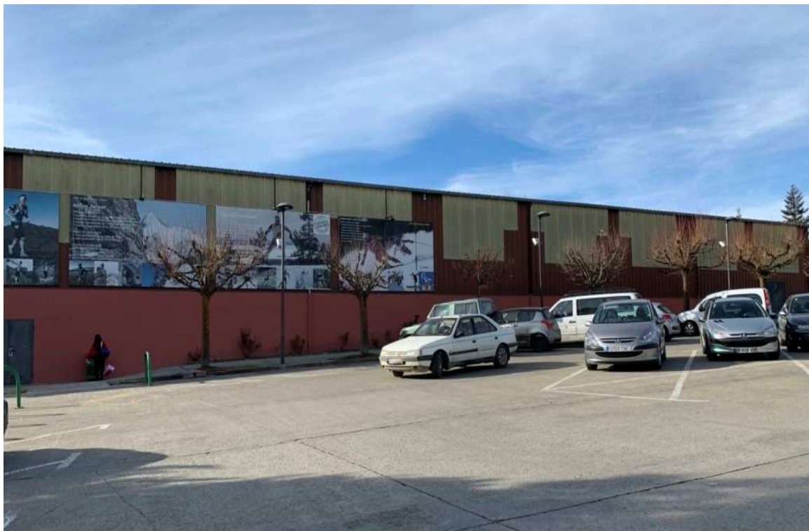
Exterior de la pista de gel del poliesportiu de Puigcerdà. / G.L.T.
