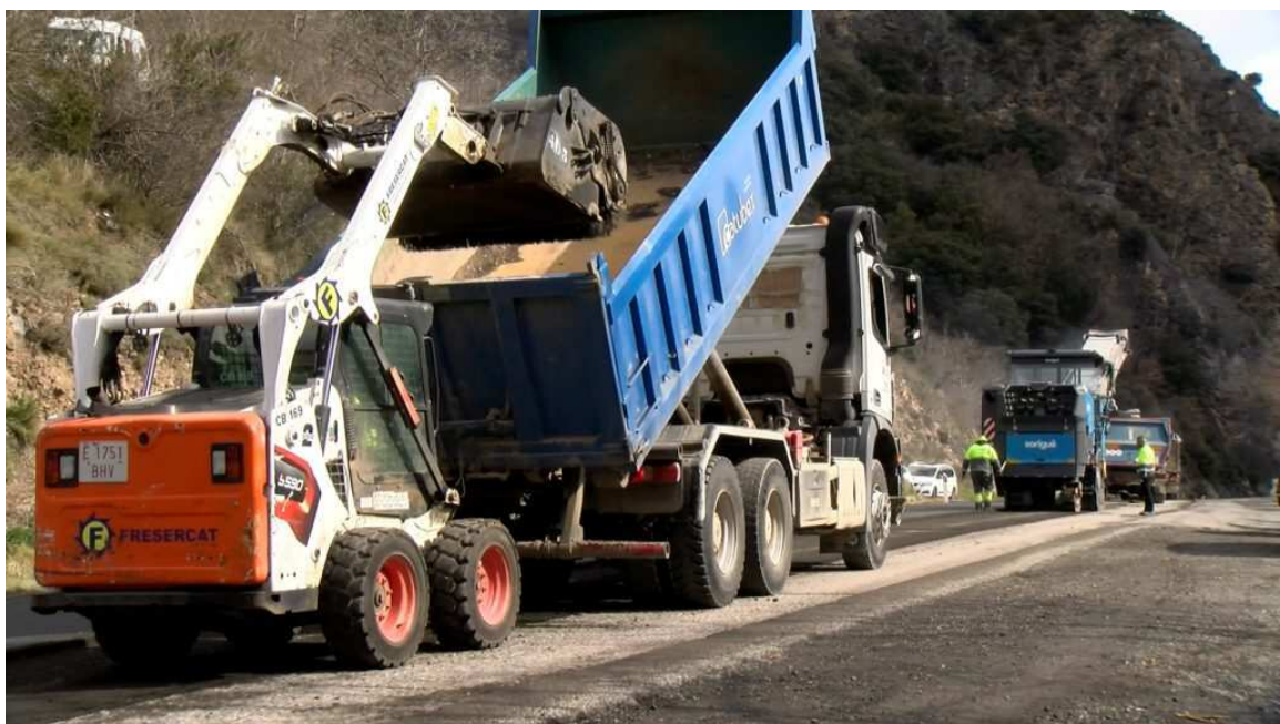
Camió treballant en la rehabilitació del ferm de l'N-260 a Estamariu / J.P.O.
