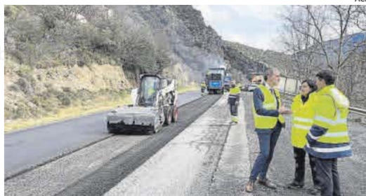
José Crespín durant la visita a les obres
