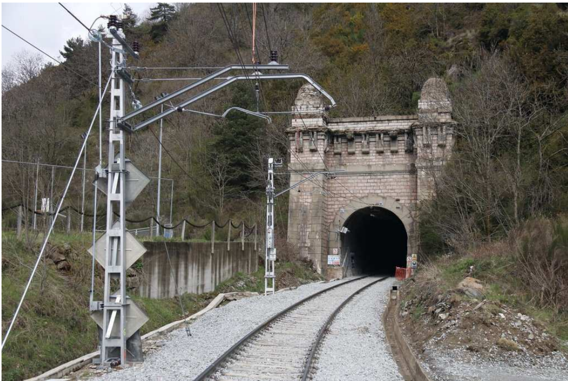
Entrada del túnel de Toses (Ripollès) per on hi circulen els trens de l'R3 en direcció a Puigcerdà / ACN
