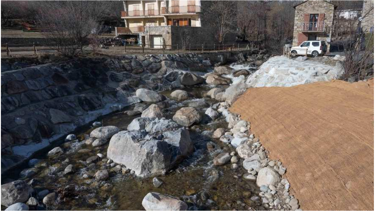
La rivière après les travaux menés durant deux mois et demi. - Frédérique Berlic
