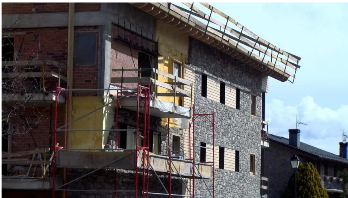
Obres de construcció de pisos a Bellver de Cerdanya / M.F.C.
