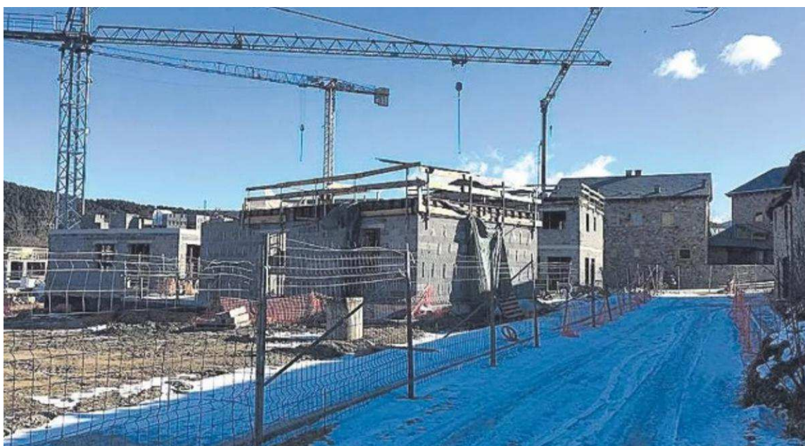
Construcció de segones residències a Bellver / MIQUEL SPA
