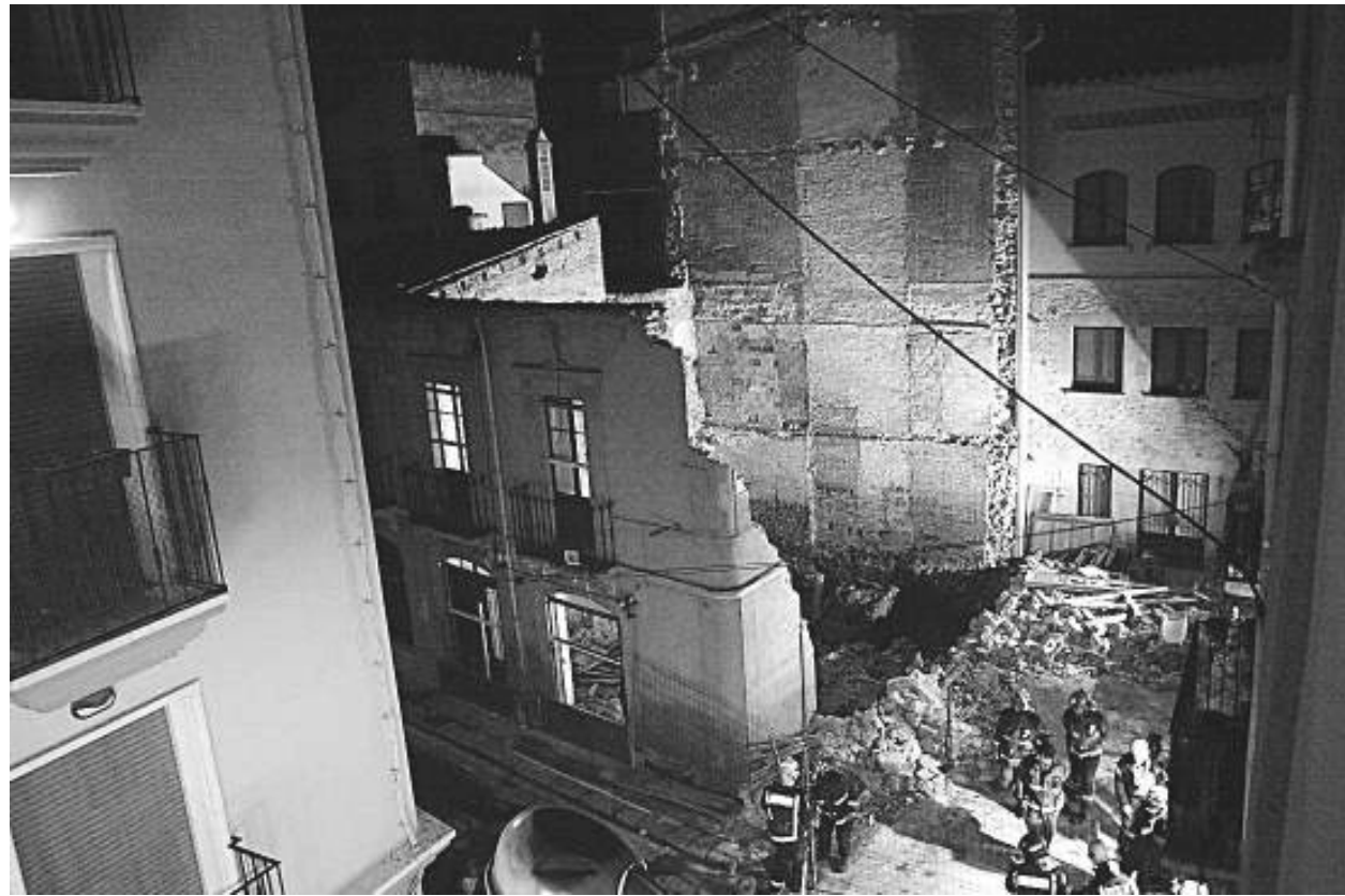
Els operaris rehabilitaven l'edifici conservant-ne la façana, que té valor arquitectònic. / LLUÍS SERRAT
