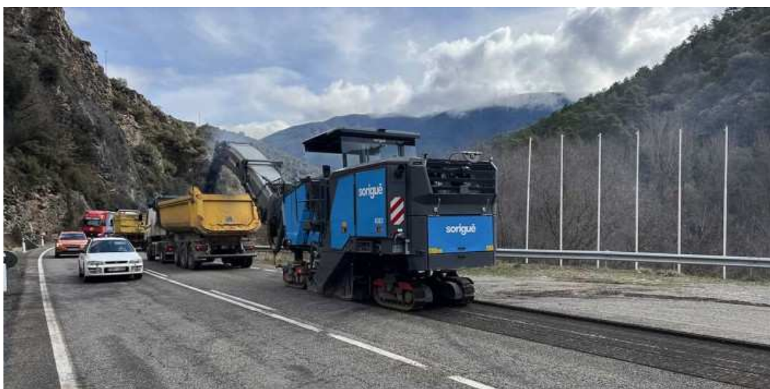
Les obres a l'N-260 entre la Seu d'Urgell i Bellver de Cerdanya, per abans de Setmana Santa Autor/a: ACN
