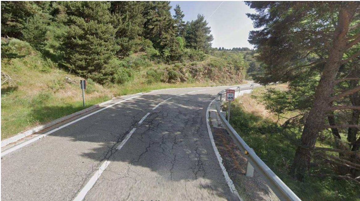
Inici del tram del quilòmetre 165 a l'N-260, al terme d'Alp / GOOGLE MAPS
