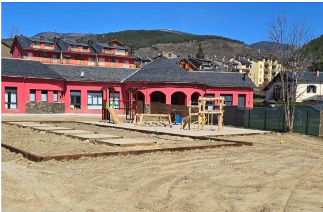
Obres de millora del pati de l'escola Jaume I de Llivia / Aj. de Llivia
