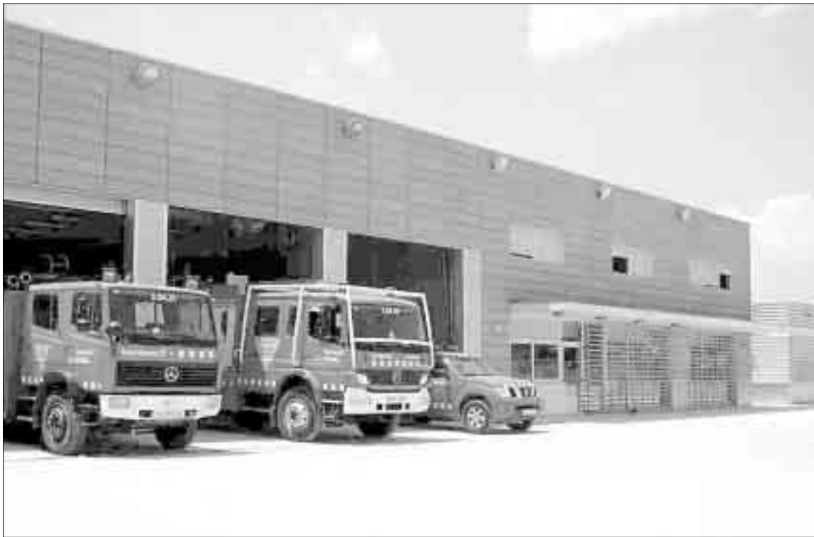
LA PERA. El nou parc de bombers substitueix el de la Bisbal, que havia quedat obsolet.
