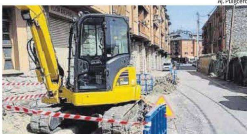
Obres al centre de Puigcerdà
