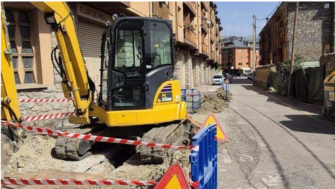
Obres al centre de Puigcerdà / AJ PUIGCERDÀ
