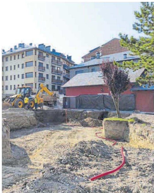
Obres de fonamentació de l'ampliació del Casal de la Gent Gran
