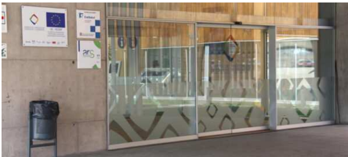
Pla de detall de la porta d'accés a l'interior de les instal·lacions de l'Hospital de Cerdanya. Imatge del 13 de març de 2020 (Horitzontal).
