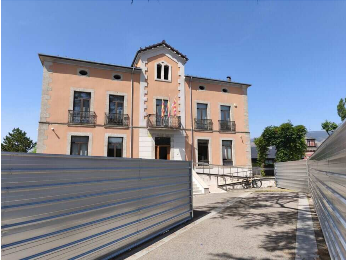
Obres d'ampliació del Casal Comarcal de la Gent Gran de la Cerdanya / @CCerdanya
