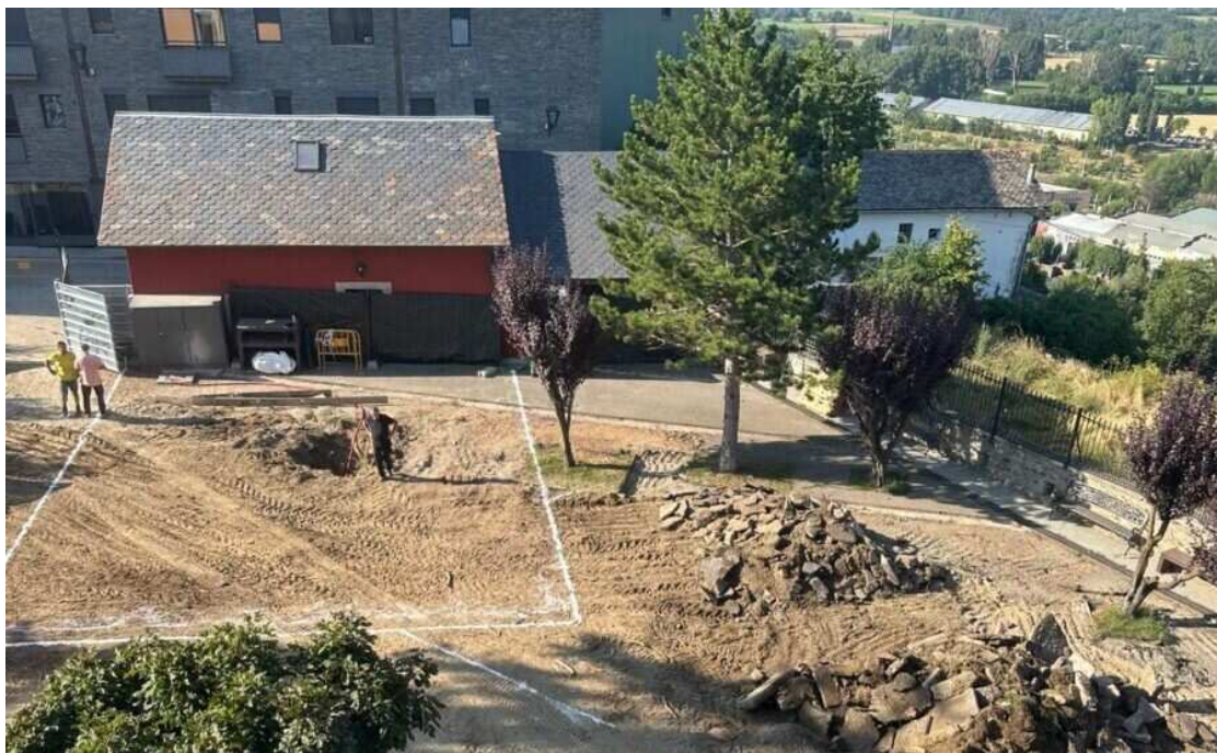
Obres d'ampliació del Casal Comarcal de la Gent Gran de la Cerdanya / @CCerdanya
