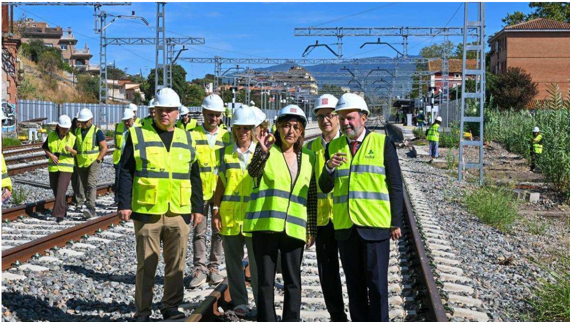
La conseller Sílvia Paneque en la visita d'aquest dijous a les obres de l'R3 / Gencat
