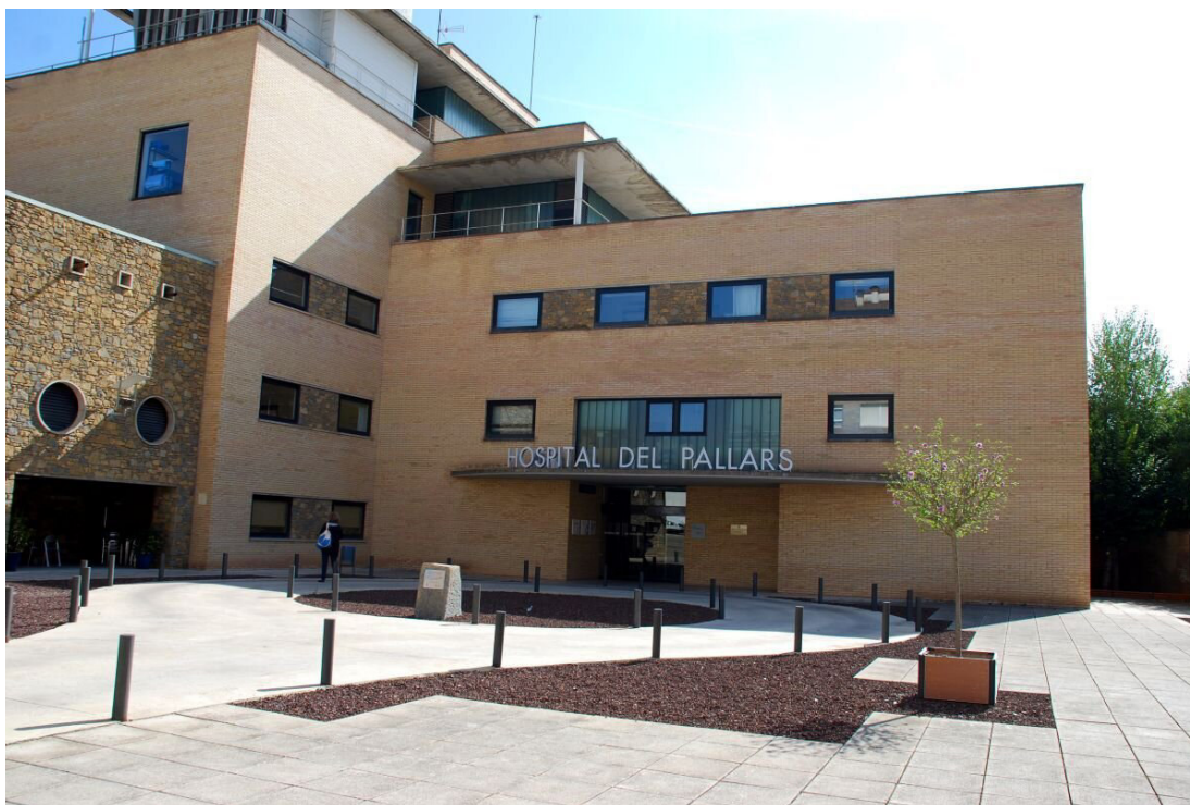
Hospital del Pallars a Tremp / Marta Lluvich
