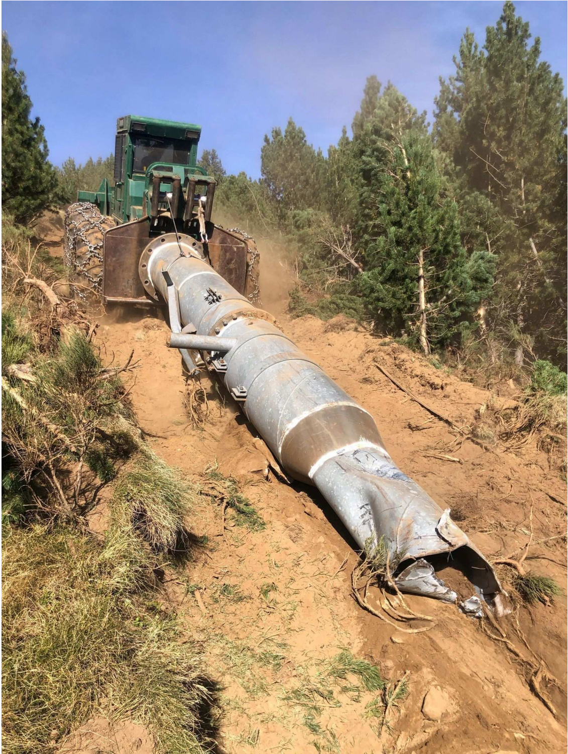
Una de las pilonas del telesilla de Puyvalador ya desmontada. Foto: L'Independant
