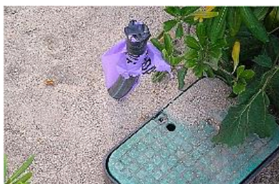
Un tub amb el precinte lila, que indica que porta aigua regenerada. tossanatura.blogspot
