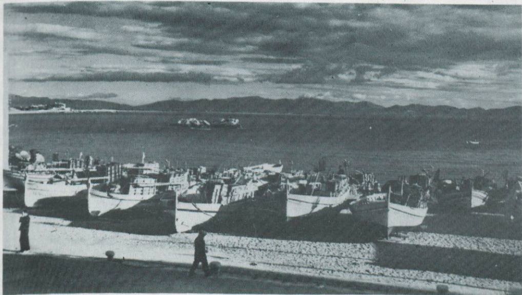
A L'Escala, el 12 d'agost del 1897, tothom temia el pitjor a conseqüència d'un accident marítim que alarmà la població, quan un dels bots de pesca volcà enmig de la badia, degut a una maniobra de la vela.
