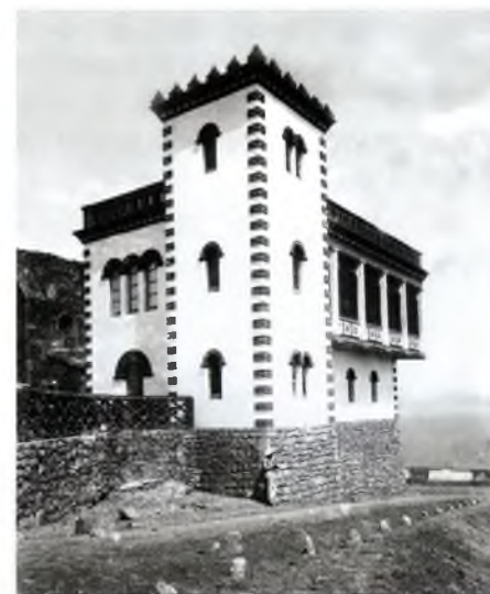
Vista de la Casa Forestal, edifici de serveis del Cuerpo Nacional de Ingenieros de Montes, projectada pels mateixos i acabada de construir el 1910. / Foto: J. Esquirol; AHE.
