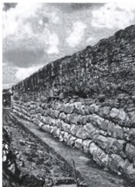
Vista parcial de la muralla romana després de l'excavació feta pels Amics de l'Art Vell el 1934. / Foto: Museu d'Arqueologia de Barcelona; col. de l'autor.
