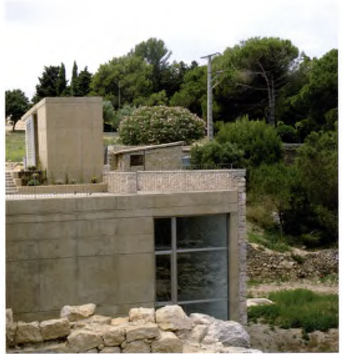
El nou edifici dels magatzems arqueològics d'Empúries un cop finalitzada la seva construcció. / Foto: J. Curto, MAC-Empúries.
