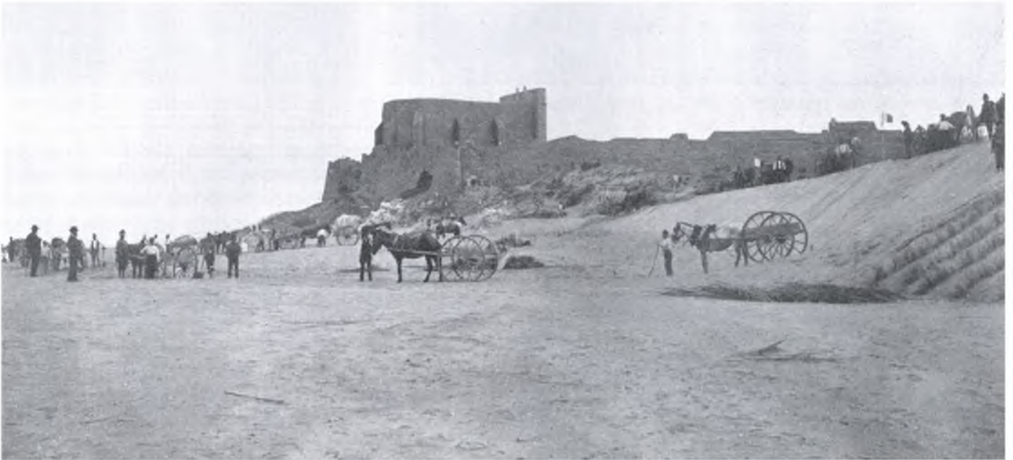
Treballs del procés de fixació de les dunes d'Empúries.
