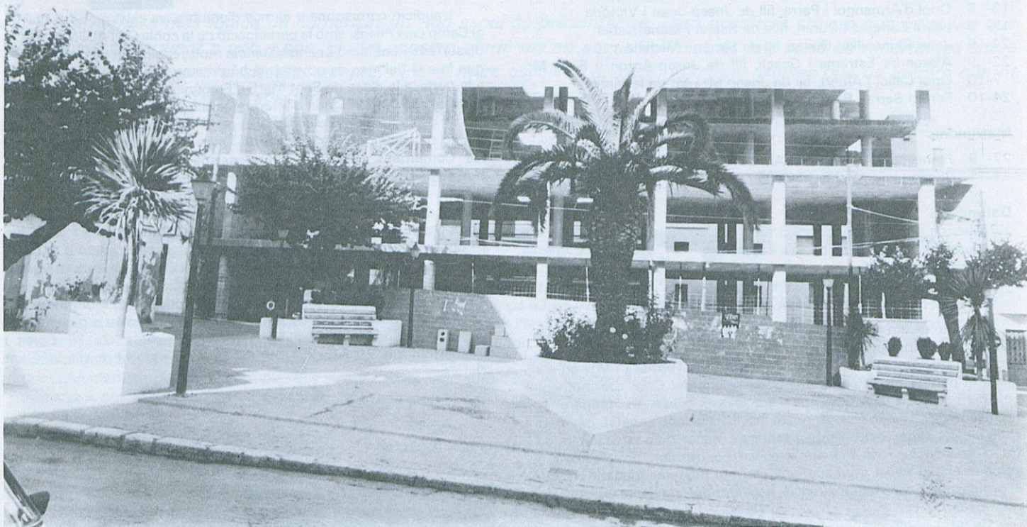
La construcció del Nou Edifici de la Casa de la Vila, momentàniament aturada.
