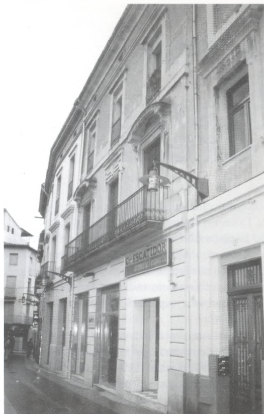
Estat actual de l'edifici del carrer dels Dolors
